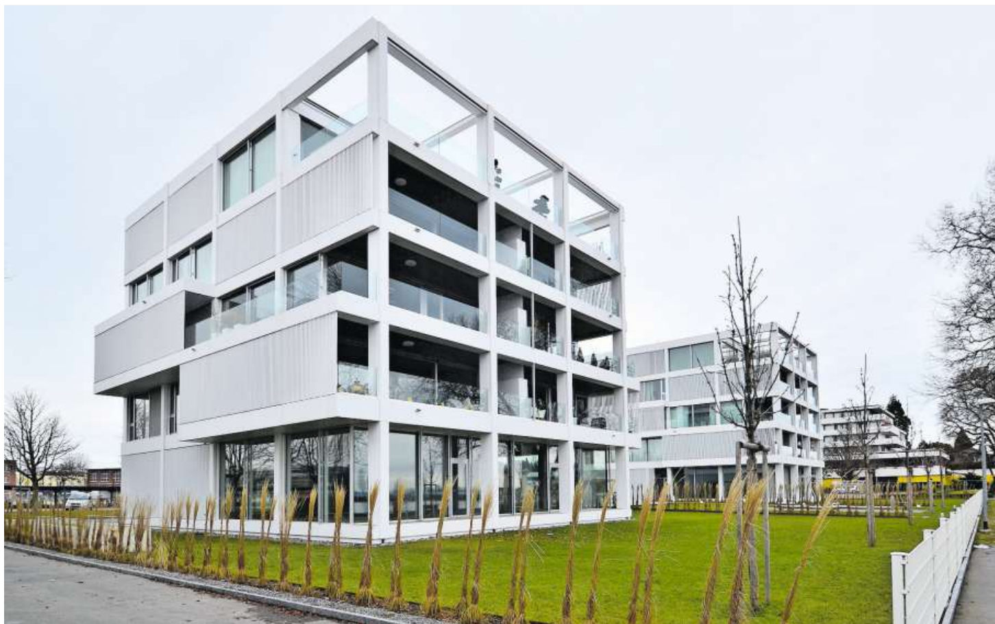
Häuser am See: Mängel bei Attikaterasse behoben, Gutachten zur Fassadenkonstruktion liegt in drei Wochen vor.
