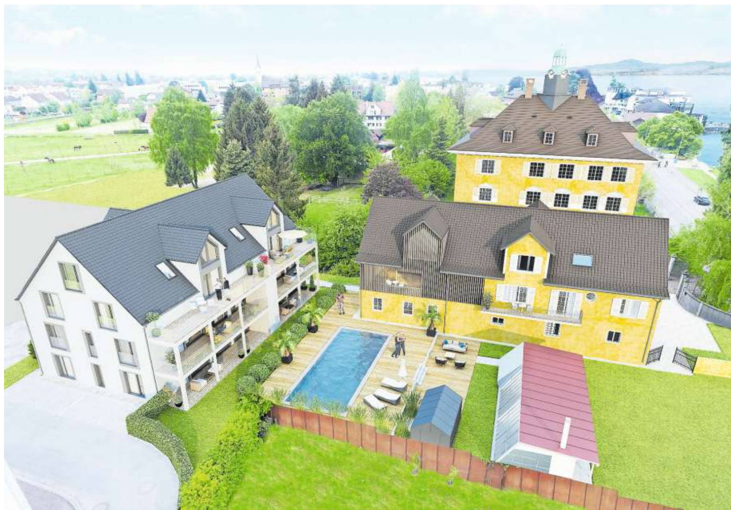
Teile der historischen Gebäude sind denkmalgeschützt. Der Kanton Thurgau machte beim Projekt Auflagen.
