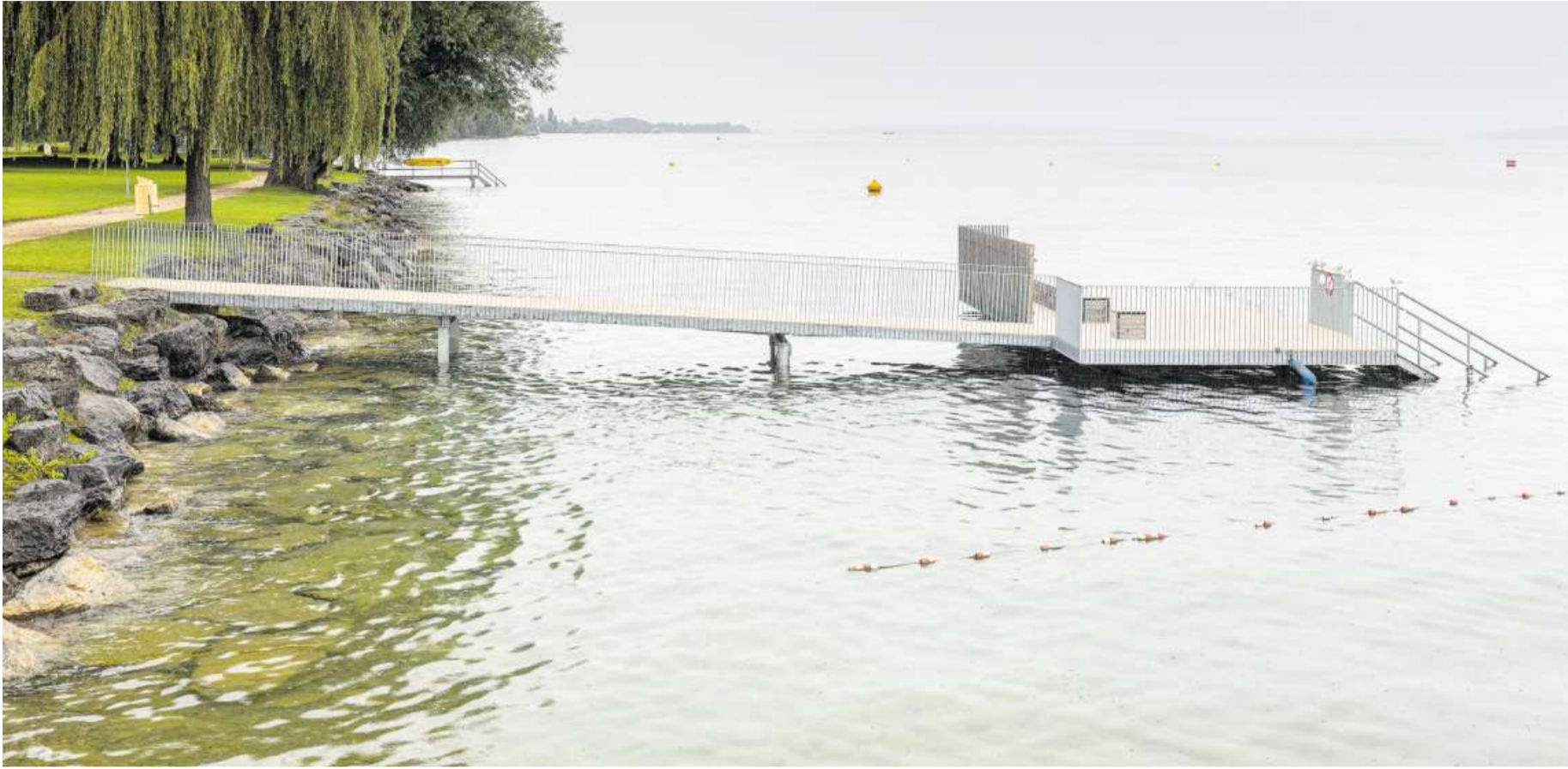
Das Wasser kommt dem Steg immer noch gefährlich nahe.
